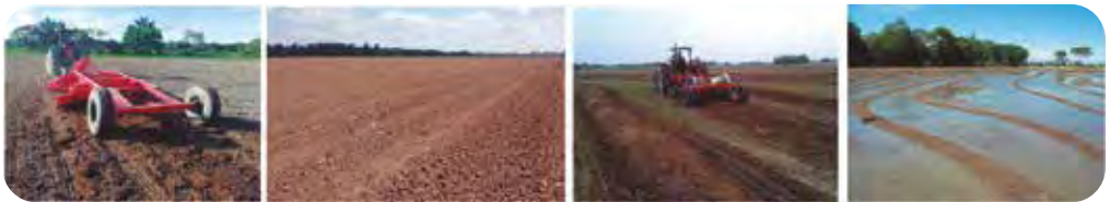
Figura 10. Micronivelación y caballoneo durante la adecuación de suelos
