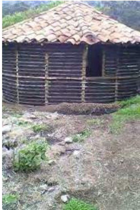
Figura 6. Territorio Misak. Construcción para conservación de Semillas.
