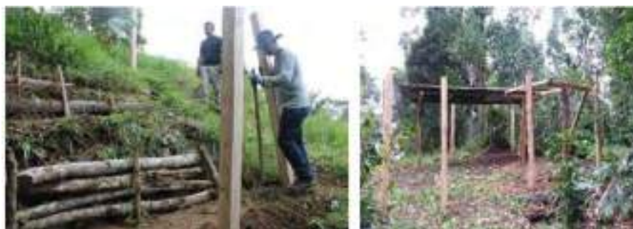
Figura 2. Adecuación del terreno e infraestructura apícola
