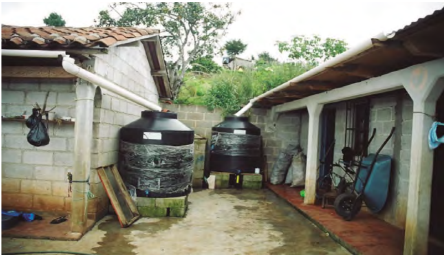
FIGURA 3.11 Sistema de recolección de agua lluvia.
